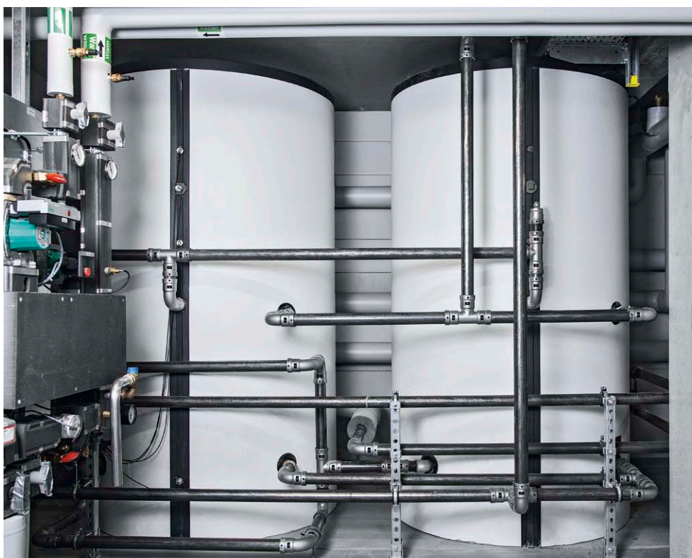
Megapress i en varmeinstallation med bufferbeholdere.
