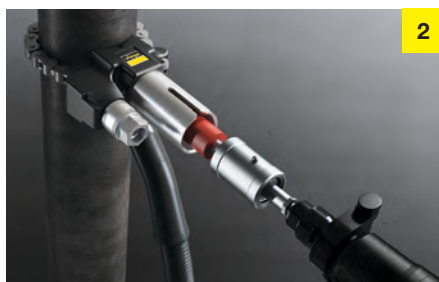
2 Boring af hullet med boreakslen og en standard boremaskine, derefter afmontering af holdeanordningen.
