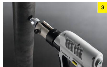
3 Indpresning af indpresningsstudsene i røret med presmaskine og presindsats.
